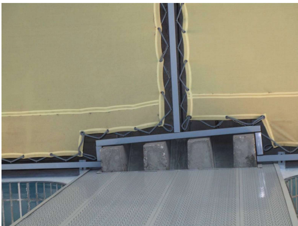
Photo 3 – Détail connexion poteaux - poutre
