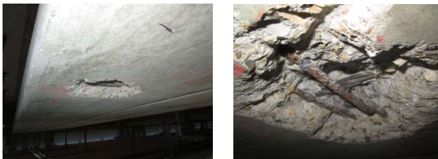
Photo 7: Sondage SD3 – Poutre en travée
